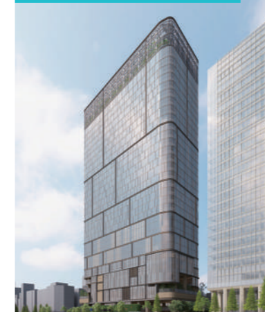
虎ノ門一丁目東地区第一種市街地再開発事業 (2026年度竣工予定)
