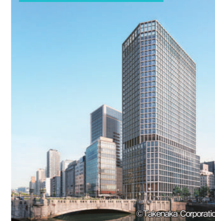
淀屋橋駅東地区都市再生事業 (2025年5月竣工予定)
